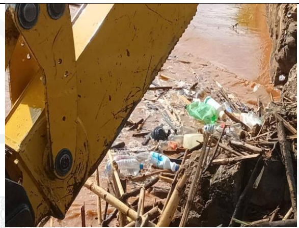
Ilustración 6 Palizada bloqueando el paso del agua del otro lado del puente.
