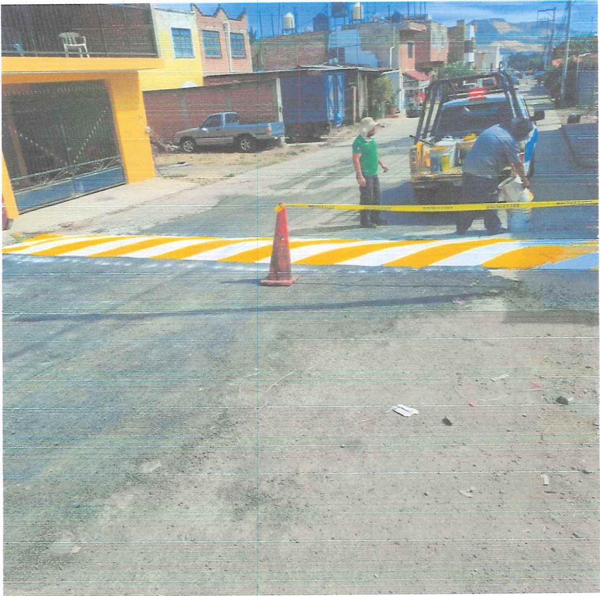
Balizamiento de reductores de velocidad
