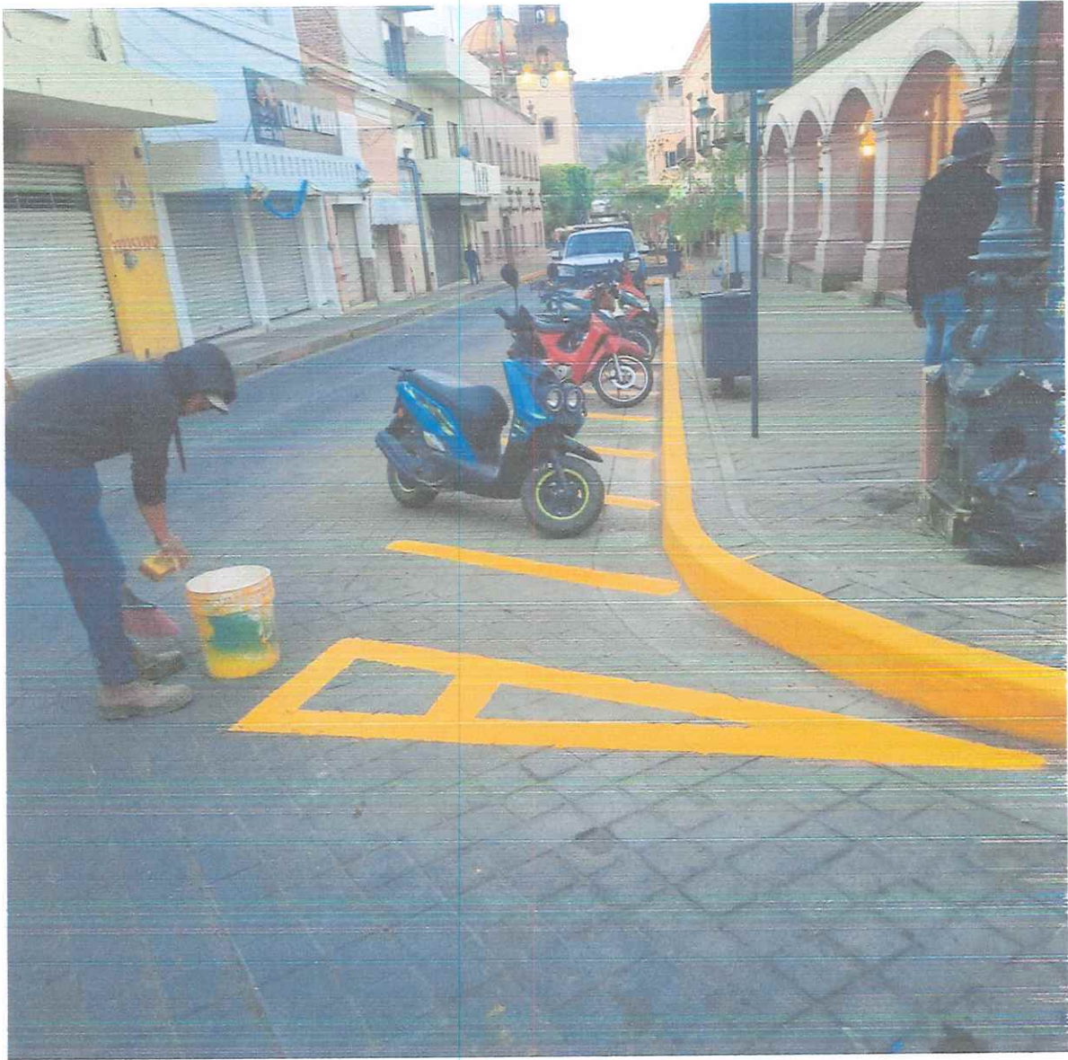
Balizamiento de cajones para motocicletas en zona centro
