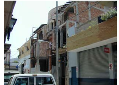
Edificación no armónica frente al mercado, volumetría y tipología no adecuada
