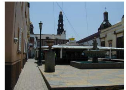
▶ Adecuaciones deficientes en espacios urbanos.
