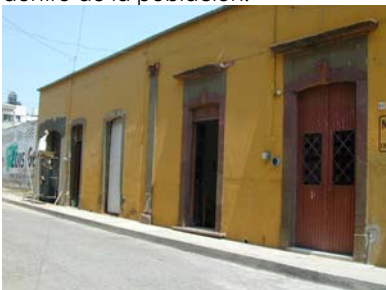
▶ Elementos tipológicos predominantes de la arquitectura.
